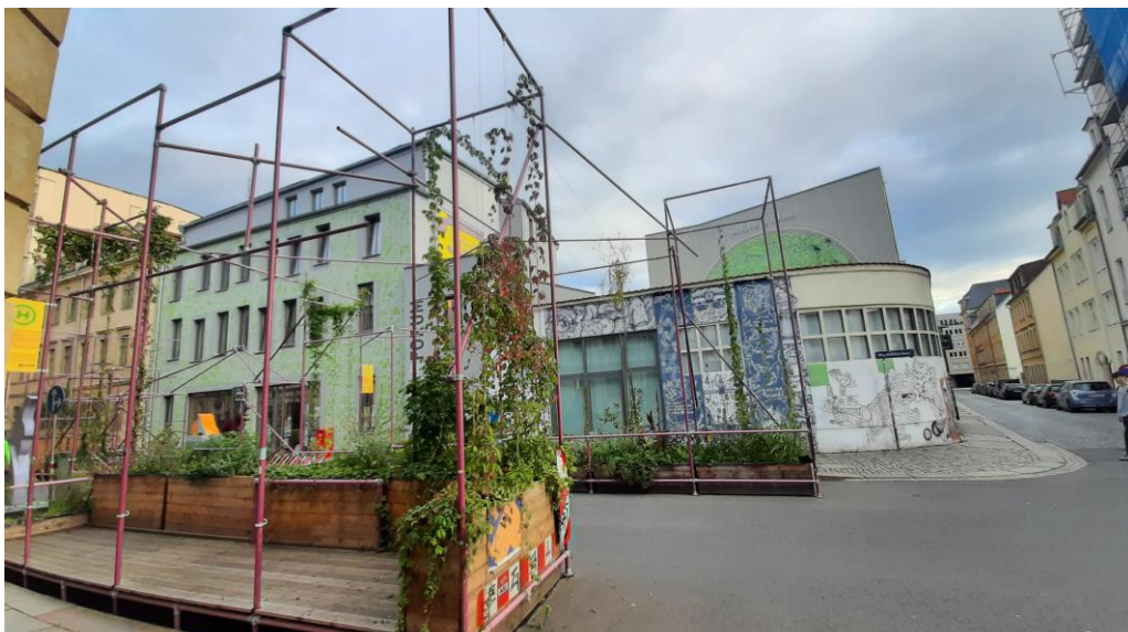
Mehr Generationenhaus Dresden
